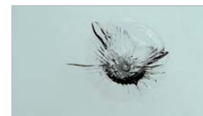
b) razdrobljena poškodba
